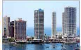
EDIFICIO - Edificios de más de 10 pisos se están construyendo en Concepción y en Coquimbo. El más alto está en Viña del Mar, con 17 pisos y 10 departamentos, en la zona de Playa Brava.
